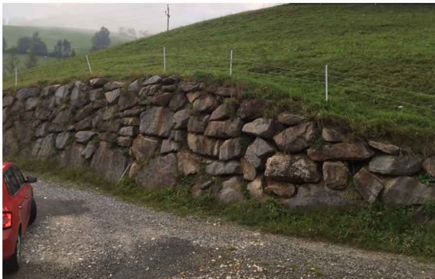
Zufahrt (alt) im Bereich Bauplatz Nr. 9 - durch Hangsicherungsmaßnahme nicht mehr möglich
