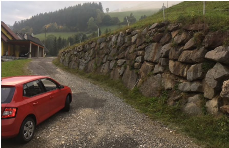
Zufahrt (alt) im Bereich Bauplatz Nr. 8 - durch Hangsicherungsmaßnahme nicht mehr möglich
